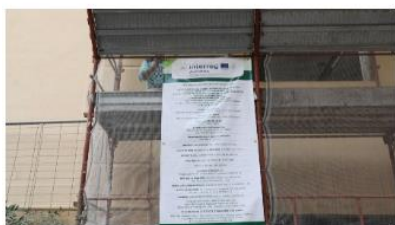
PROGETTO ECOBATI – IL CANTIERE PILOTA DI CUNEO
