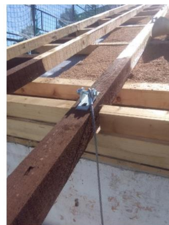
PROGETTO ECOBATI – PARTICOLARE DEL TETTO, CANTIERE PILOTA DEL COMUNE DI BOVES
